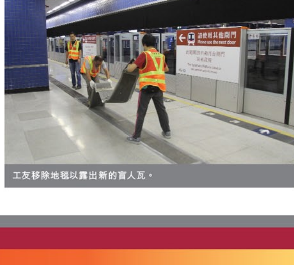
工友移除地毯以露出新的盲人瓦。
